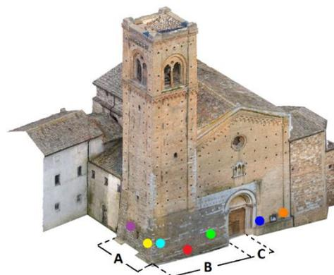
Figura 3. Distribuzione spaziale delle distanze utilizzate per scalare il modello fotogrammetrico (a, b e c) e dei punti di verifica utilizzati per l'analisi dei residui dopo l'allineamento della nuvola fotogrammetrica con la nuvola TLS.
