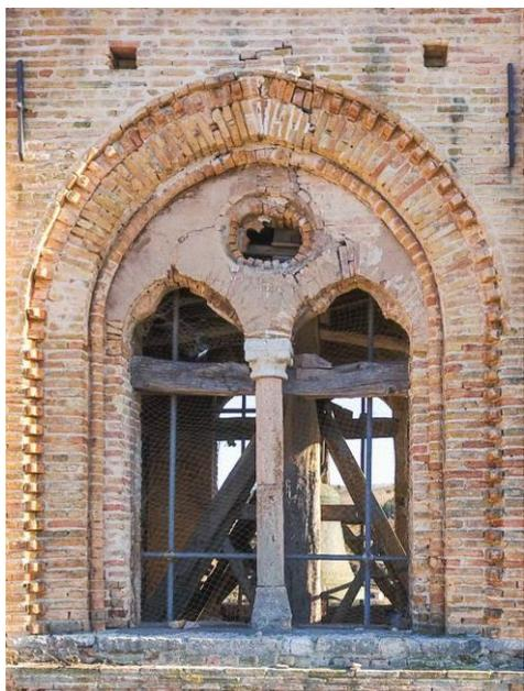
Figura 6. Foto da drone della bifora disassata (ovest) del campanile del Duomo Vecchio di San Severino Marche. Sono visibili i danni causati dal sisma del 2016.
