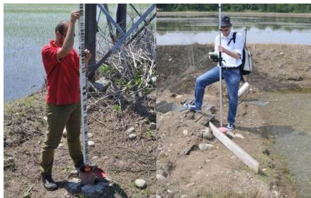
Figura 5. Piezometri rilevati tramite livellazione geometrica (altimetria) e misure GNSS (planimetria)
